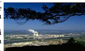
Centrale nucléaire de Tricastin - EDF
