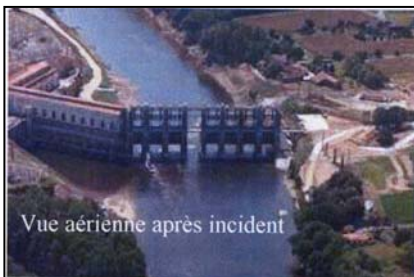
Vue aérienne après incident Les Tuilières dam - Source : EDF
