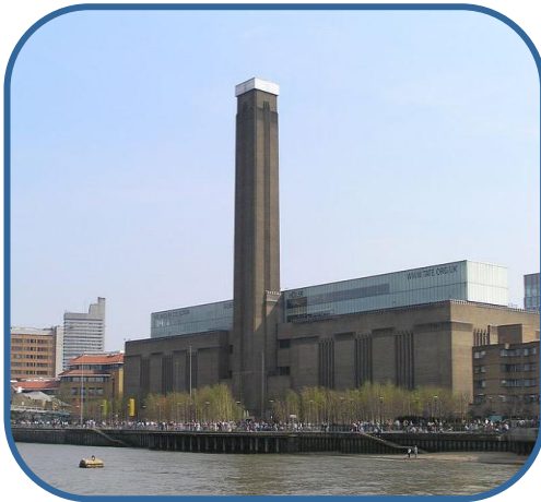
Infrastructure vieillissante (production et réseaux)
