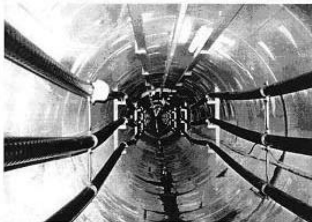
Photo: 380-kV câbles et jonctions dans le tunnel (avant peinture pour la protection de l'incendie)
