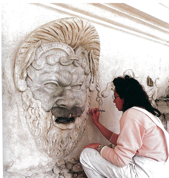
Masque de théâtre, en cours de restauration, corps central de la façade sur jardin de la Villa Médicis à Rome. Achèvement du nettoyage. Ph. SEI.
