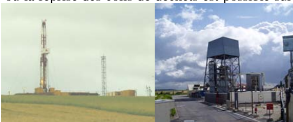
Forages et puits à Bure
