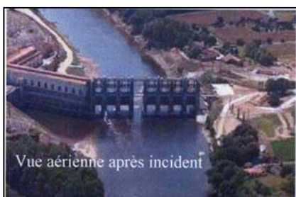
Barrage des Tuilières - Source : EDF
