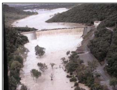
Barrage écrêteur de crue de la Rouvière lors de la crue du 9 septembre 2002, supérieure à sa crue de projet de sûreté. Source : AIGREF n°19
