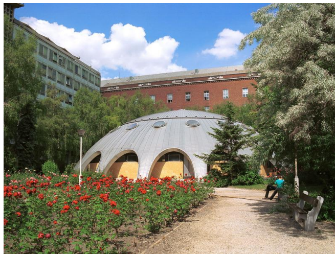
Réacteur de recherche de l'Institut des techniques nucléaires (source : BME).
