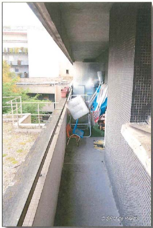
Le balcon vu à hauteur de la fenêtre de la cuisine en direction de son accès.
